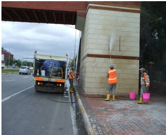
Üst Geçitlerin Temizlenmesi İşi
