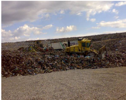
Çöpün serilmesi ve sıkıştırılması
